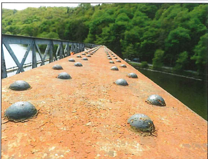
Foto č. 20 – Konstrukce K 04 – horní pásnice hl. nosníku
