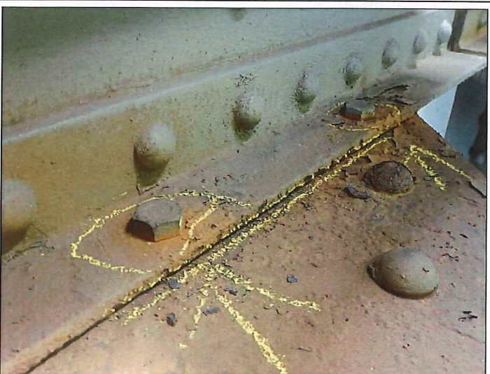
Foto č. 15 – Konstrukce K 03 – podélník na začátku – volné šrouby ve spoji s příčným
