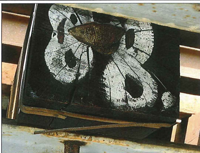
Foto č. 24 – Konstrukce K 05 – mostnice č. 54 – dřevokazná houba
