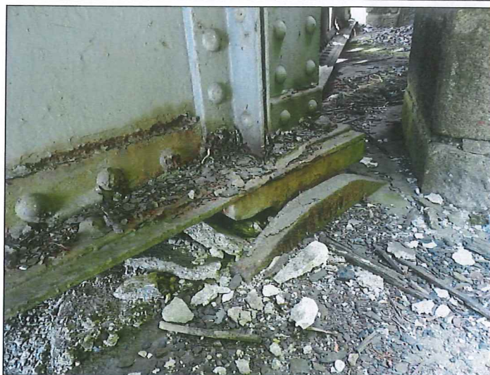
Foto č. 7 – Konstrukce K 01 – ložisko na opěře O 01 vlevo
