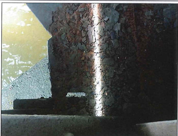
Foto č. 14 – Konstrukce K 02 – dolní styčnickový plech nad ložiskem vpravo prokorodovaný
