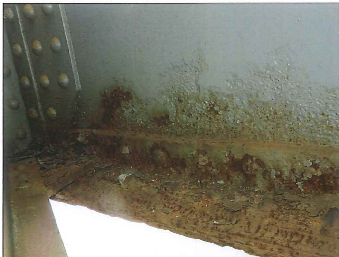
Foto č. 4 – Konstrukce K 01 – korozní oslabení podélníku
