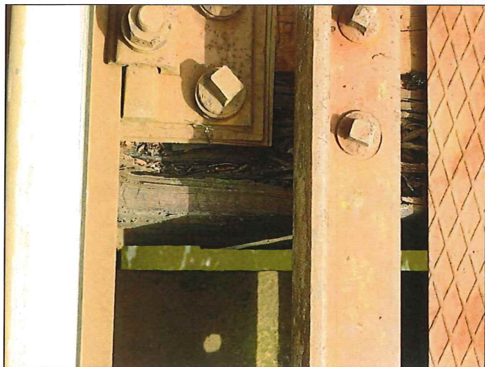
Foto č. 21 – Konstrukce K 04 – mostnice č. 37 vyhnílá
