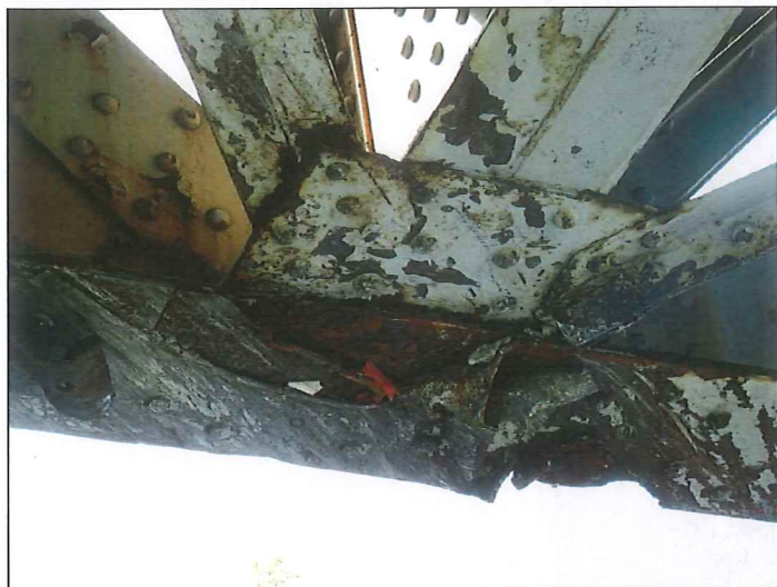
Foto č. 10 – Konstrukce K 02 – hlavní nosník – dolní pásnice pod svislicí č. 3 vlevo – deformace, tržení, chybějící hlavy nýtů i nýty
