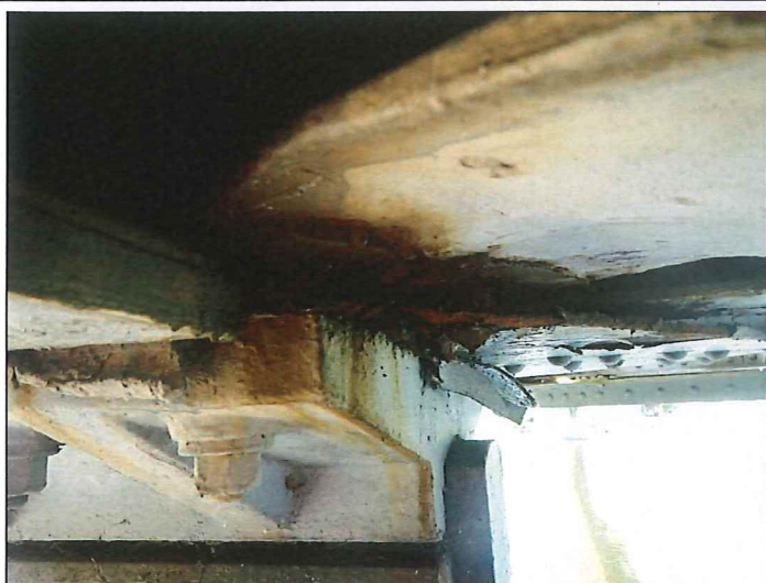
Foto č. 23 – Konstrukce K 05 – hlavní nosník – korozní oslabení nad ložiskem
