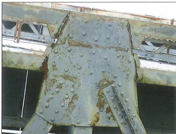
Foto č. 22 – Konstrukce K 05 – z podhledu – korozní oslabení dolního pasu hl. nosníku na styku s vodorovnou styčnickovou deskou
