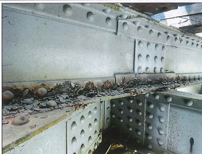
Foto č. 5 – Konstrukce K 01 – korozní oslabení podélníku
