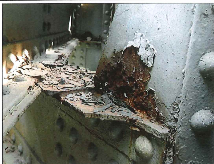
Foto č. 6 – Konstrukce K 01 – příčník res. svislý styčník nad P 01 prokorodovaný
