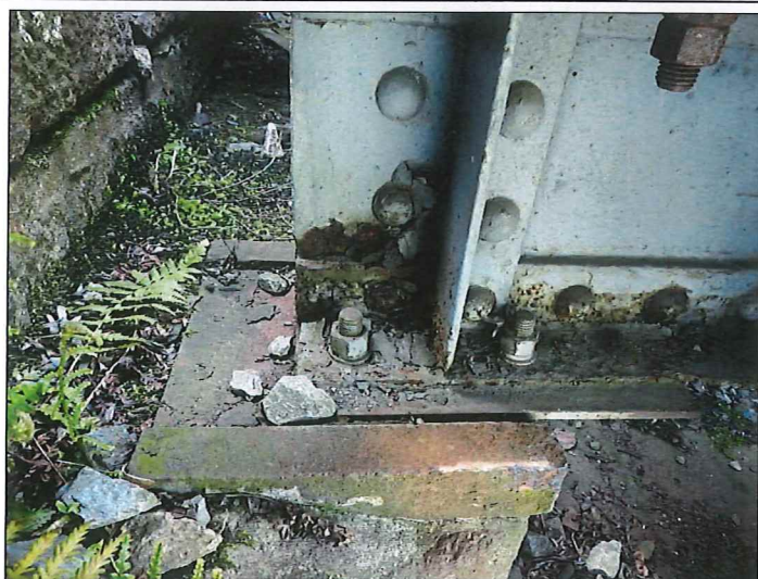
Foto č. 8 – Konstrukce K 01 – podružné ložisko na opěře O 01 vpravo
