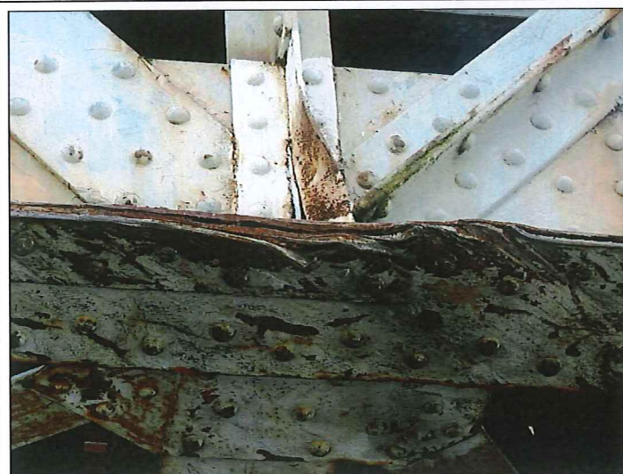
Foto č. 12 – Konstrukce K 02 – hlavní nosník – dolní pásnice v příhradě č. 3 vpravo – deformace, tržení, chybějící hlavy nýtů
