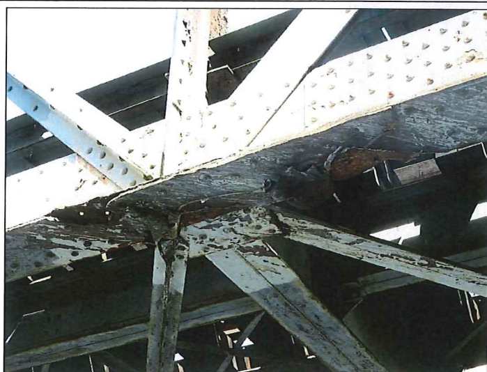
Foto č. 9 – Konstrukce K 02 – hlavní nosník – dolní pásnice pod svislicí č. 3 vlevo – deformace, tržení, chybějící hlavy nýtů i nýty
