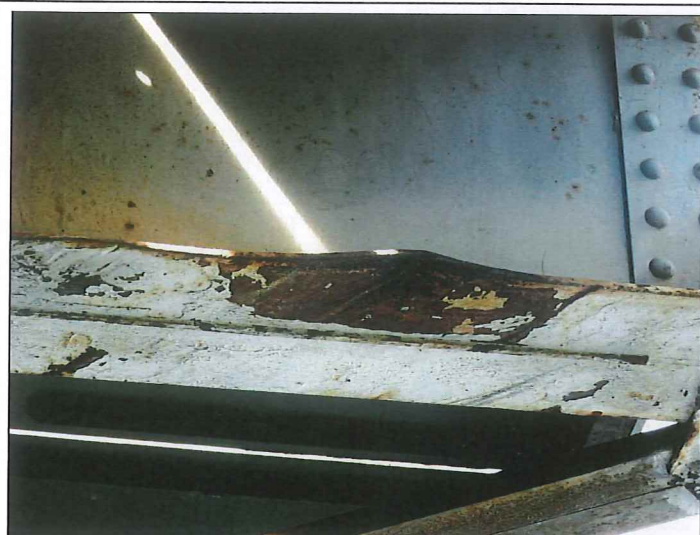
Foto č. 13 – Konstrukce K 02 – příčník – deformace dolního úhelníku
