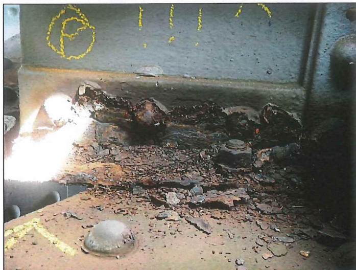
Foto č. 16 – Konstrukce K 03 – pravý podélník na konci – korozní oslabení
